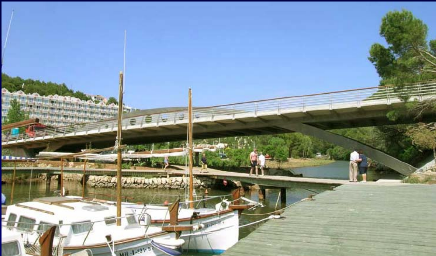
Puente Cala Galdana, Menorca
